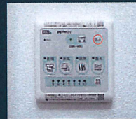
浴室暖房換気乾燥機リモコン
